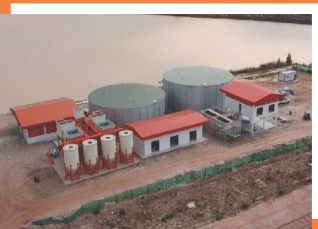
水道システム プロジェクトの貯水池は 8,000 立方メートル/日の水道を生産可能。
