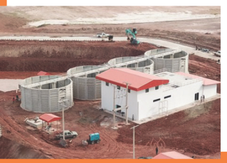
中央排水処理システム プロジェクトの処理能力は、SBR システムで 6,400 立方メートル/日。
